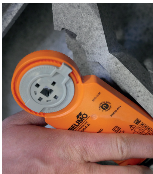
Fjern bypass-aktuator
