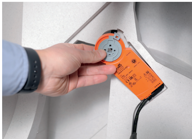
Fjern bypass-aktuator
